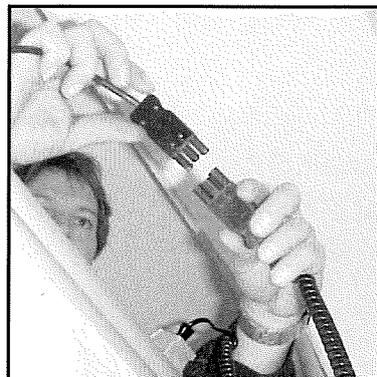
... und stellen Sie die Strom-Steckverbindung mit der oberen stromführenden Querzarge her.
